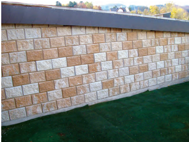
Trennwand mit Bossensteinen
